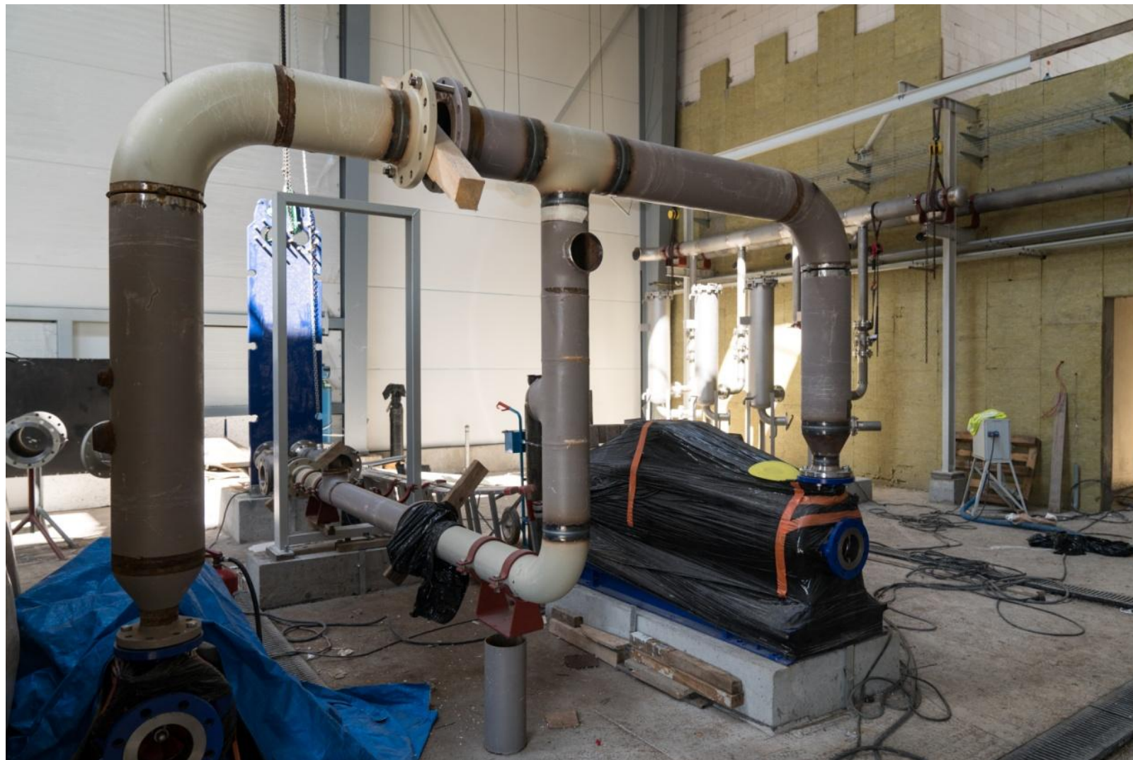
Montaż infrastruktury wewnętrznej
